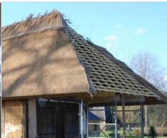
Toiture type chaume
