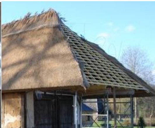
Toiture type chaume
